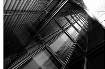
Beschichtung von Architekturglas
